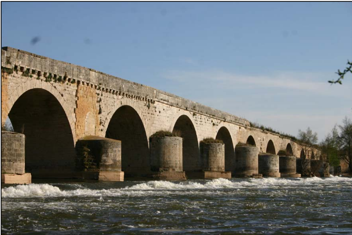
Foto N°4: Vista aguas arriba del puente en su tramo medio hacia el sur
