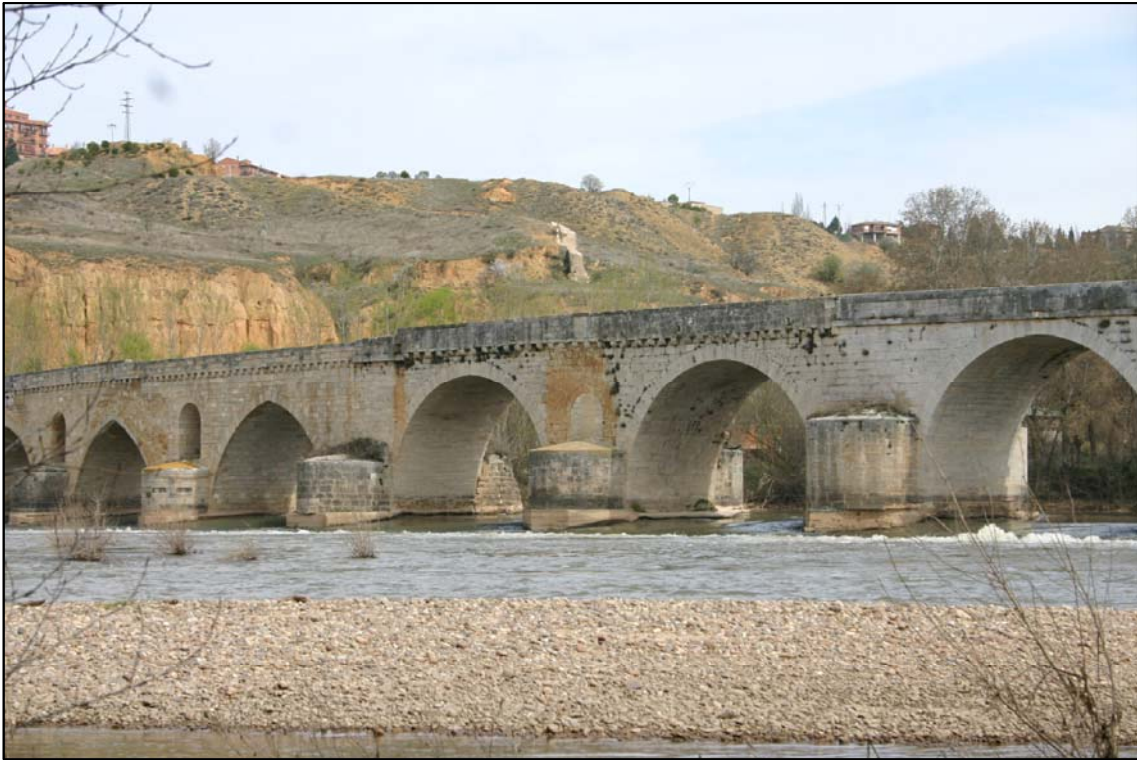
Foto N°3: Vista aguas abajo del puente en su tramo medio hacia el norte
