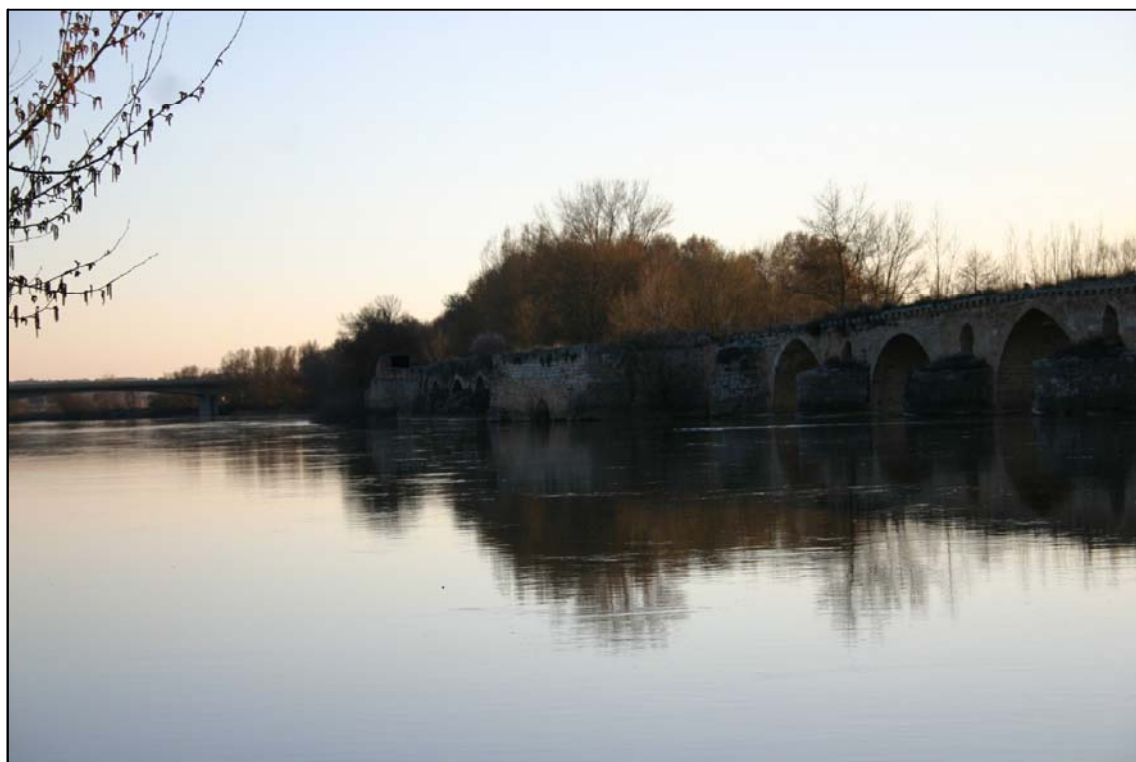
Foto N°1: Vista aguas arriba del puente en su desembarco sur
