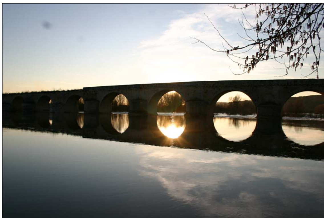
Foto N°2: Vista aguas arriba del puente en su tramo medio hacia el sur
